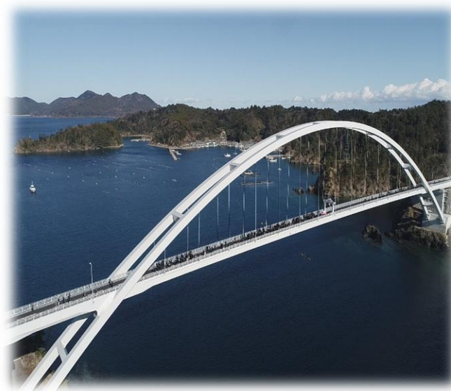
女川町 出島架橋（令和6年12月19日開通）
